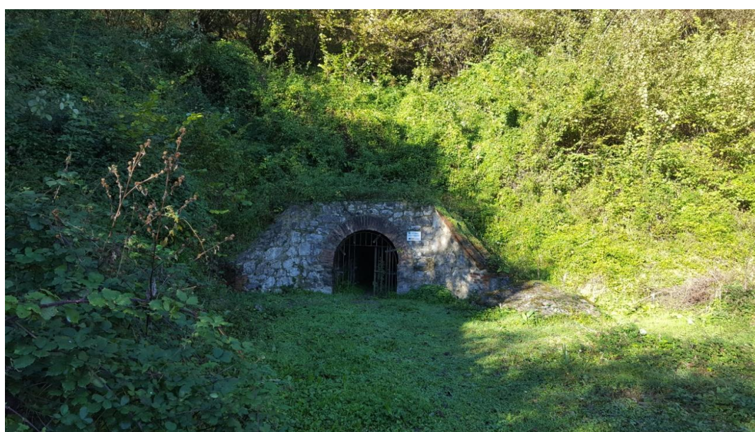
Figura 8. Socavón de Rioseco. (Fuente: propia)
