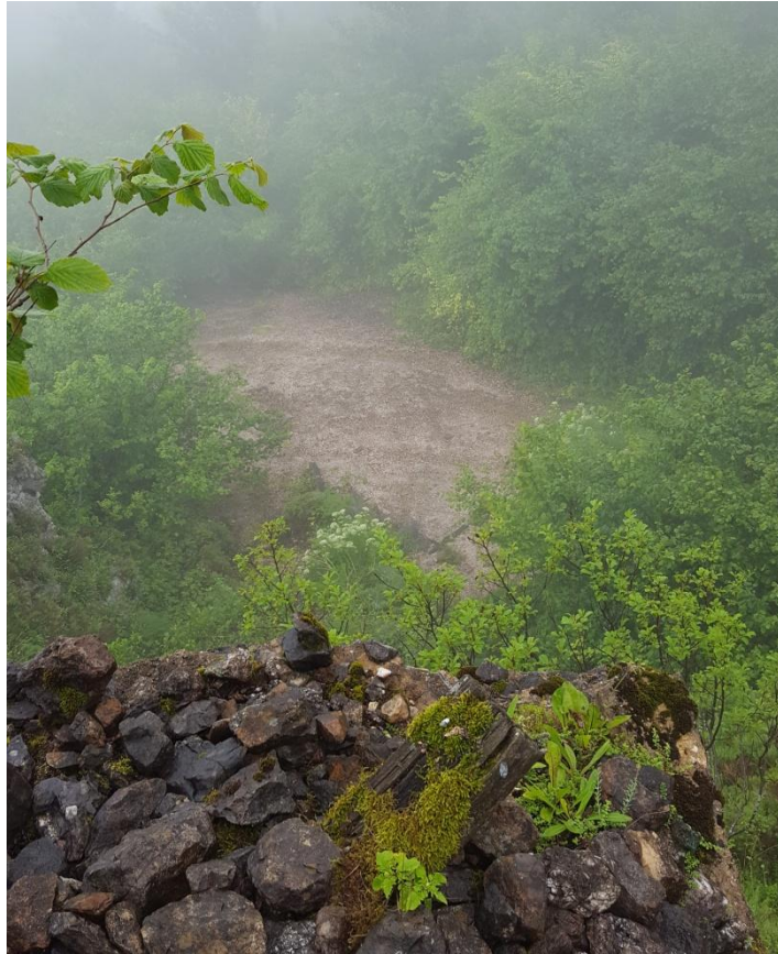
Figura 36. Escombrera del piso 1º. (Fuente: propia)
