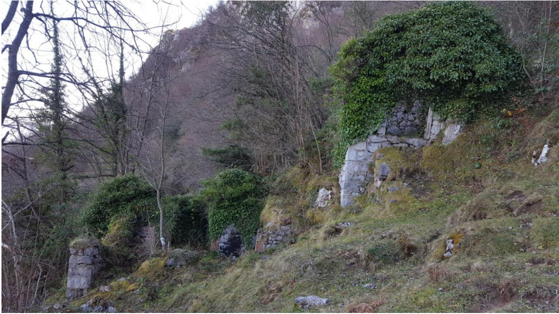
Figura 68. Fragua y edificio para compresor. (Fuente: propia)
