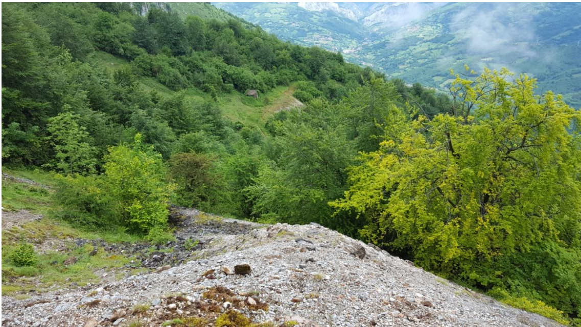
Figura 33. Escombrera del piso 3º. (Fuente: propia)
