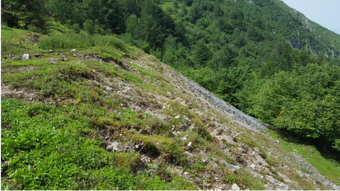
Figura 32. Escombrera del piso 4º. (Fuente: propia)
