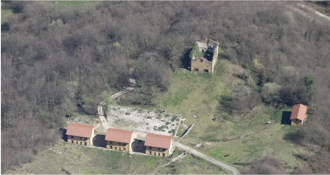
Figura 64. Viviendas, economato, edificio de la gerencia y cuadra. (Fuente: riosahistoria.blogspot.com)
