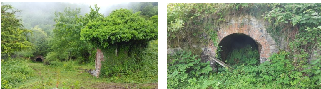
Figura 5. Bocamina del piso 2º moderno. (Fuente: propia)
