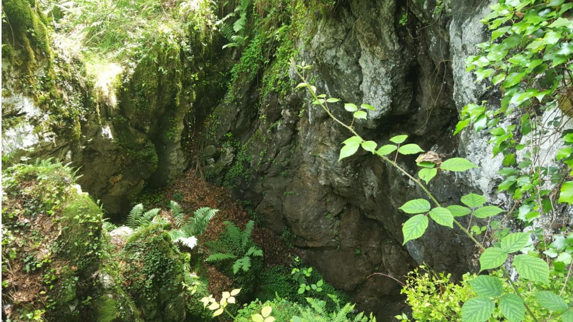
Figura 28. Entrada 10. Filón Sta Bárbara. (Fuente: propia)
