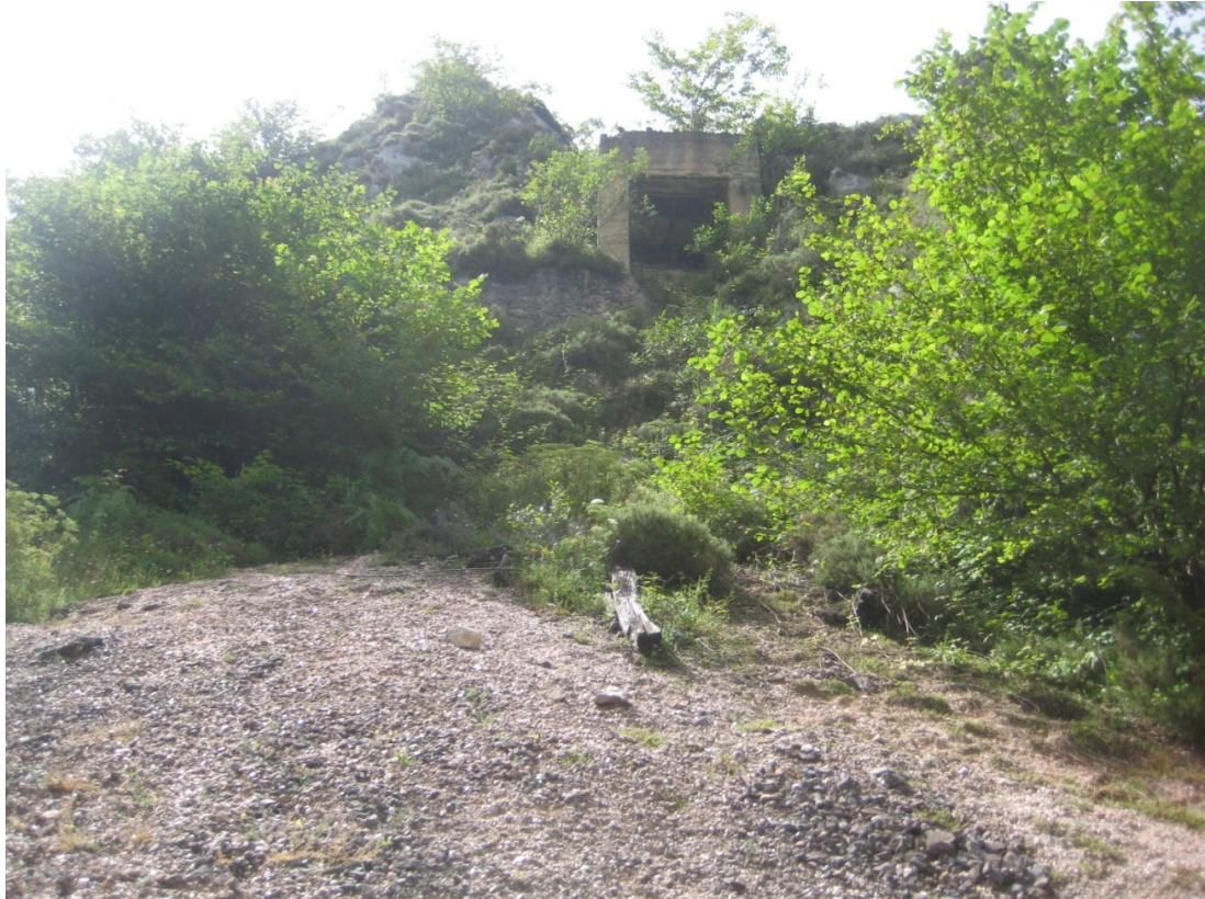
Figura 62. Inicio cable de transporte aéreo del piso 1º. (Fuente: propia)
