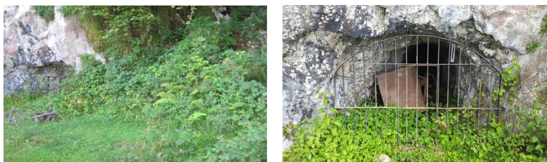
Figura 7. Bocamina del piso 1º. (Fuente: propia)
