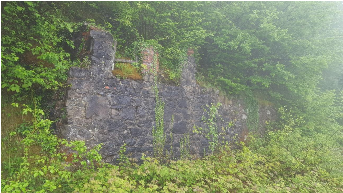
Figura 65. Cargadero del mineral proveniente de las mesas de concentración gravimétrica. (Fuente. Propia)
