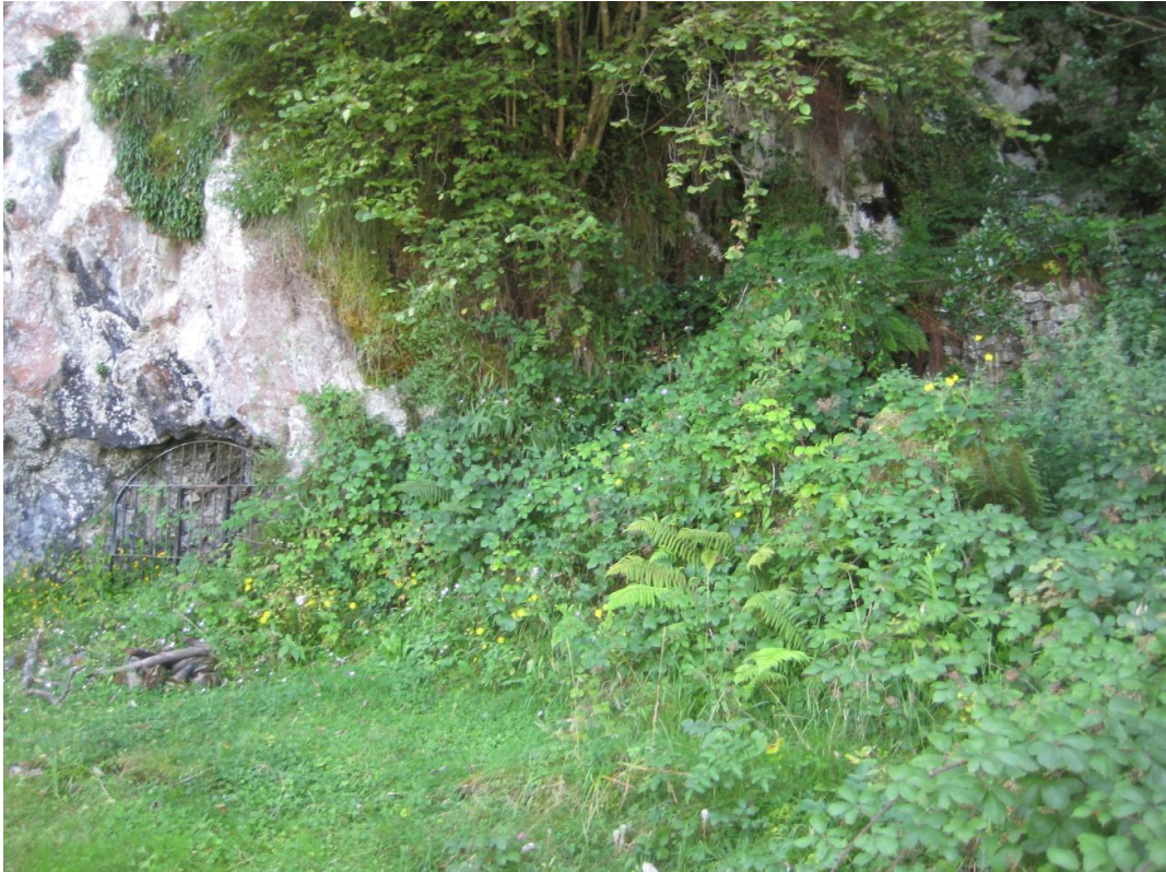
Figura 74. Tendejón para obreros y aperos en el piso 1º (a la dcha de la imagen y cubierto de vegetación). (Fuente: propia)
