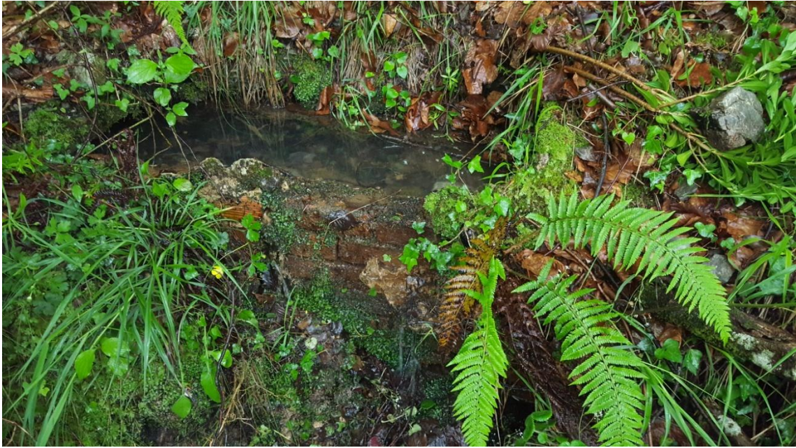
Figura 76. Detalle de la conducción de agua hacia la planta de tratamiento. (Fuente: propia)
