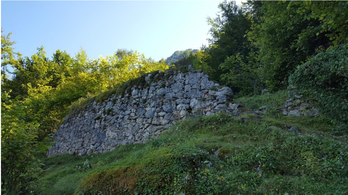
Figura 52. Muro de sostenimiento. (Fuente: propia)
