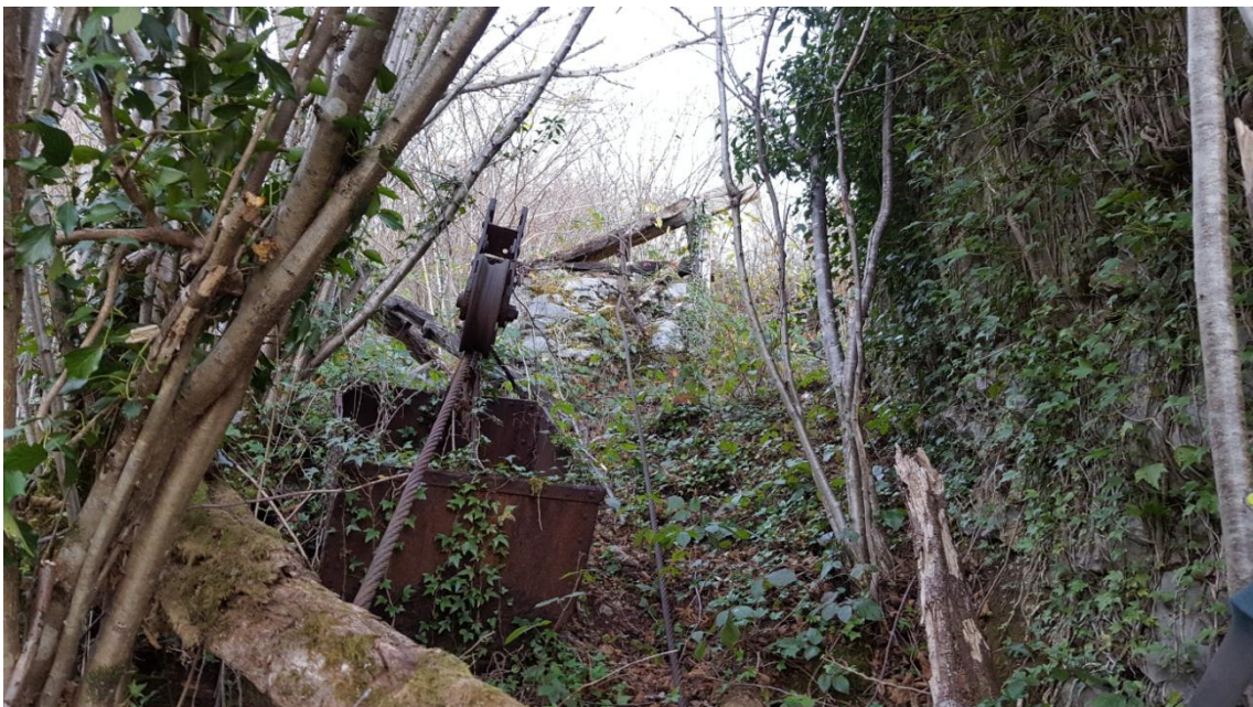
Figura 43. Elementos del cable de transporte aéreo desde el piso 2º hasta la planta. (Fuente: propia)
