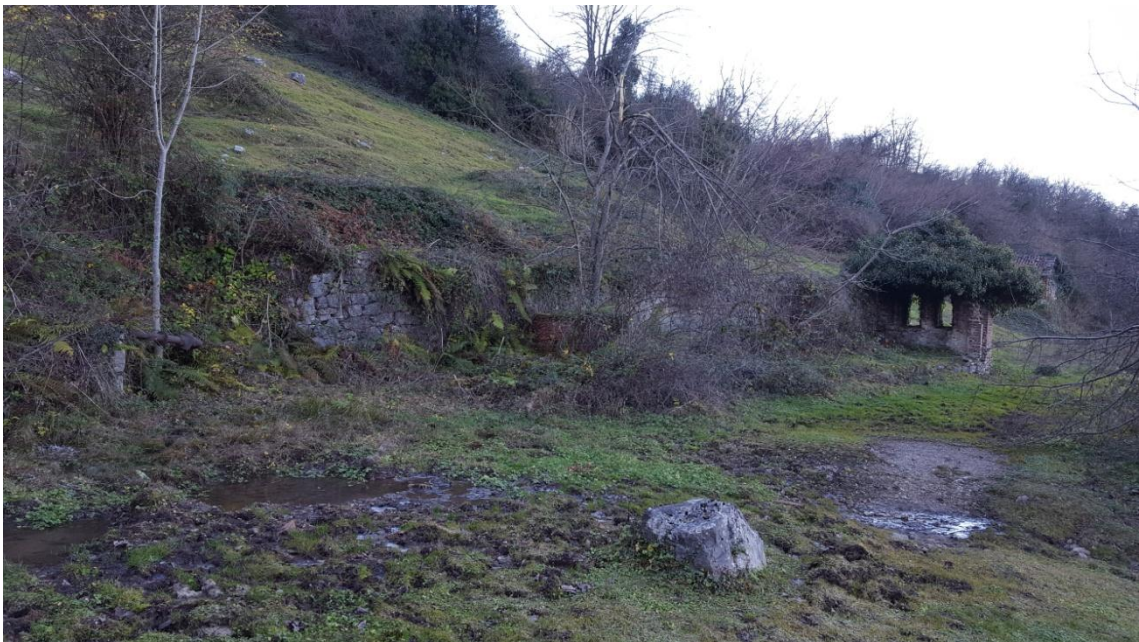
Figura 67. Tendejón con división para vigilante y “casa de aseo”. (Fuente: propia)
