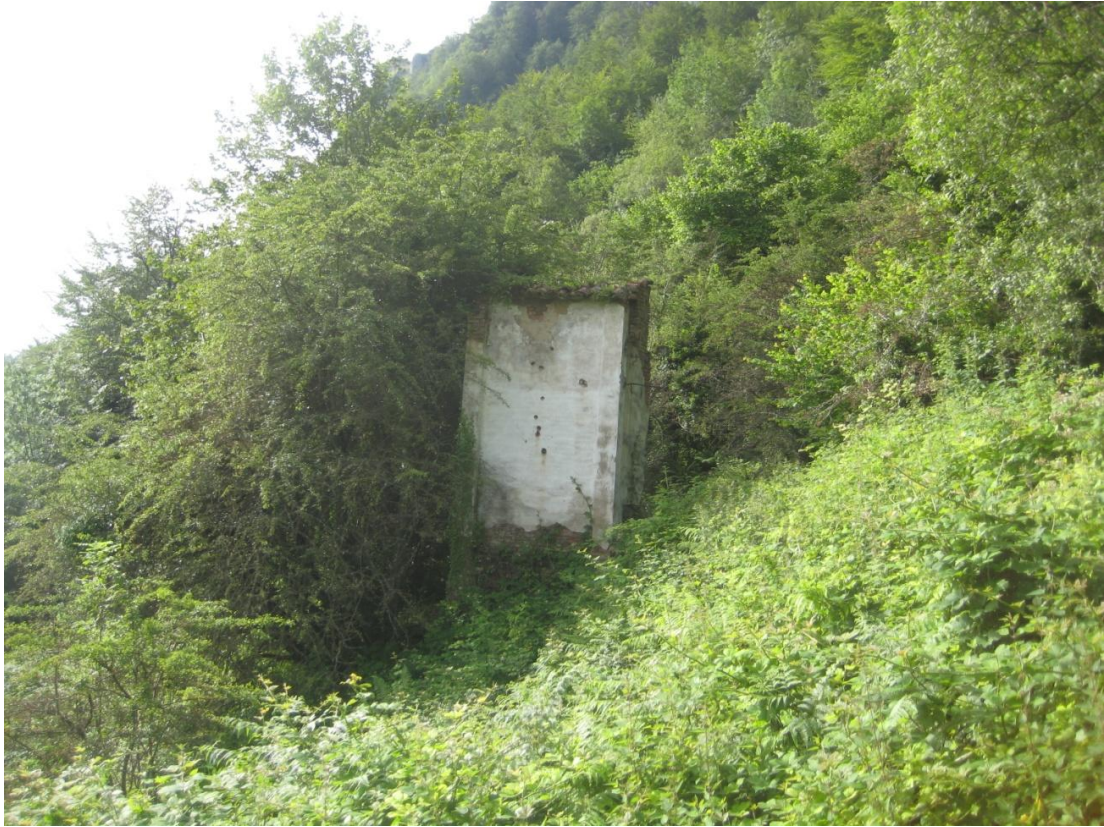
Figura 72. Transformador del piso 2º. (Fuente: propia)
