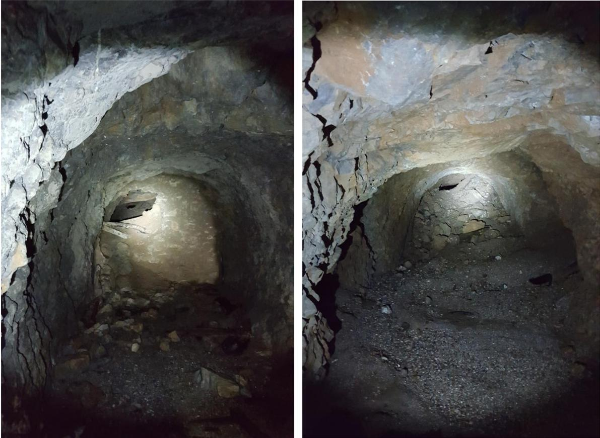
**Figura 40. Tabique y pozo escanciado sobre la galería. (Fuente: propia, 2018)**
