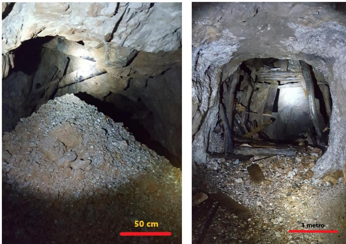
**Figura 33. Vertido de escombro sobre la galería y cargadero en madera. (Fuente: propia, 2018)**
